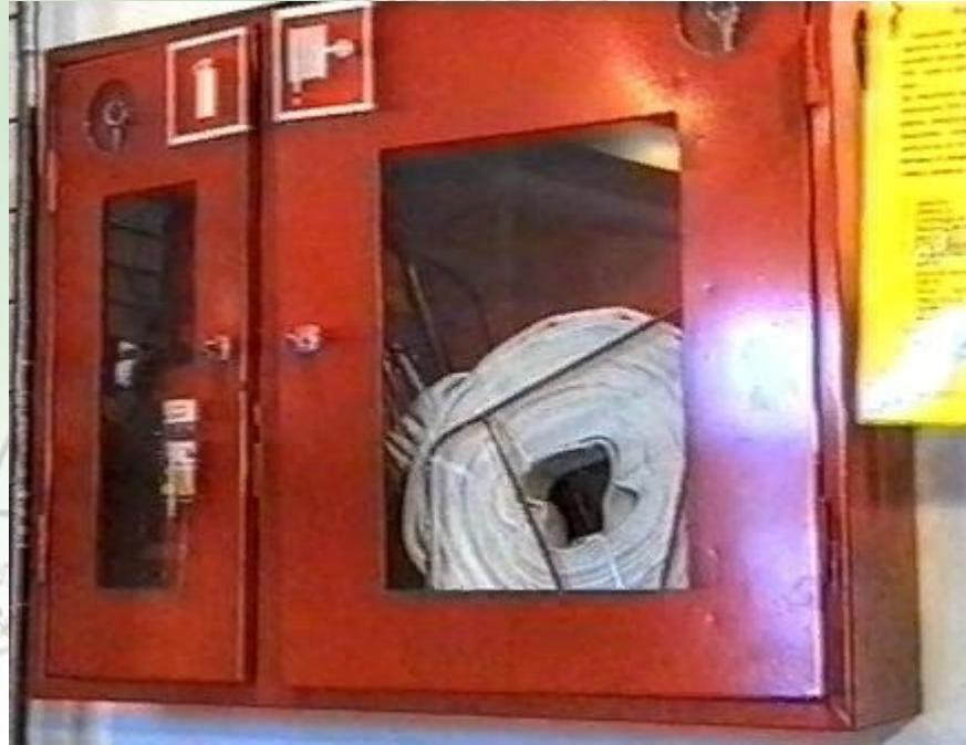
В состав пожарного крана входит клапан, установленный на внутреннем противопожарном водопроводе, оборудованный пожарной соединительной головкой, а также пожарный рукав с ручным пожарным стволом.
